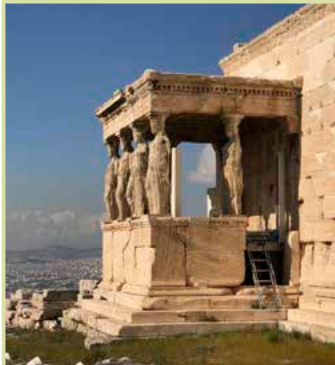
Afb. 3 Voorbeeld van een primaire bron: de Oude Athenatempel ter ere van de Griekse godin Athena Polias op de Akropolis in Athene.
